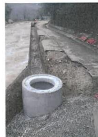
Travaux de réfection à Saint-Georges-les-Bains
