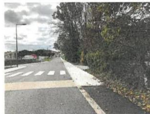
Travaux à Alboussière
