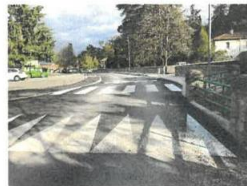
Travaux à Saint-Péray
