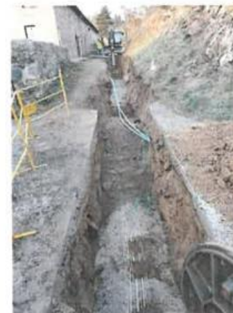
Travaux d'extension à Champis
